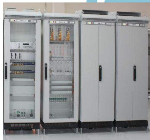
Оборудование МАБ-У для перегона Станишевка-Житомир
